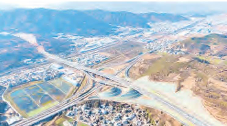
高速公路和铁路交叉点比较多,共13公里,一期通车段4.5公里。针对与原高速公路和既有铁路交叉的特点,公司成立技术攻关小组,成功上跨原大丽高速公路和铁路钢箱梁的顶推,解决了凤仪隧道下穿原楚大高速公路的施工难题。虽受疫情和征拆难度影响,我们在大理市委、市政府及各部门的支持下,顺利完成一期通车段施工任务。”
