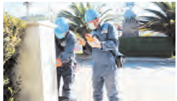
▲南方电网大理供电局开展春节电网特别巡视维护。
