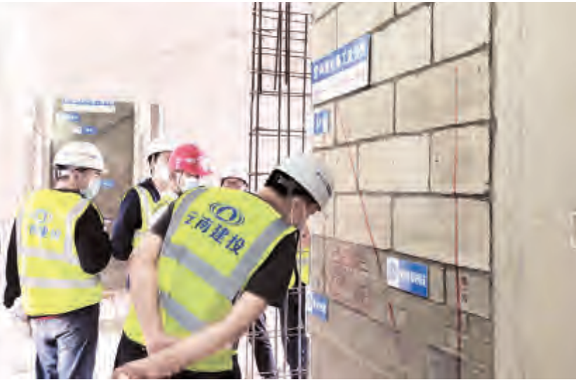
图为市住建局组织相关人员到示范项目施工现场观摩学习。
