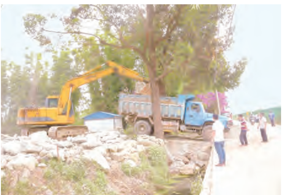
▲近日,喜洲镇村庄土地规划建设巡查员发现一农户在自家承包地内填了土石方进行建房基础平台的地皮浇灌。经查,该户并未取得任何土地、规划、建设等方面手续,属违法建设行为。为保护耕地和深入推进洱海保护治理工作,规范农村建房行为,喜洲镇政府依法对该户违法建设的基础平台和简易房进行了强制拆除。 本报通讯员 摄
