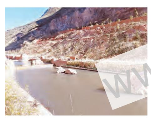
我市积极推进云浪箐矿区生态修复治理工程,通过实施边坡排险。 边坡防护、生态植被恢复、生态防洪沟修建和多塘系统建设,有效改善 了生态环境,为打赢洱海保护攻坚战、还绿水青山于民、造福子孙后代
