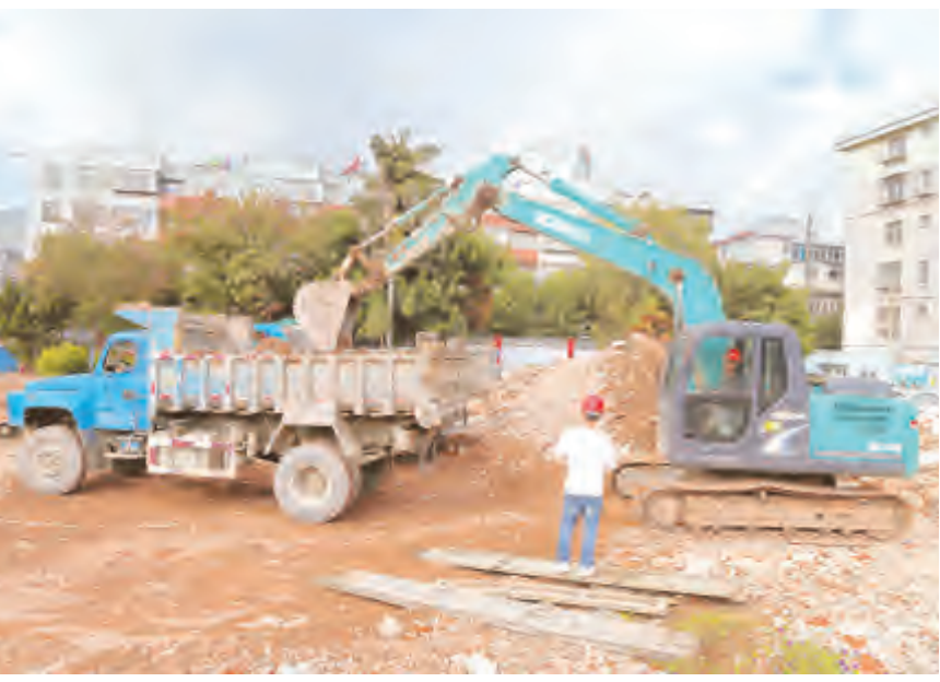
深入实际，科学指导，加强监管，为学校建设创造良好环境，使这一工程成为阳光工程、满意工程、精品工程。 记者 杨辉 马驊 摄影报道
