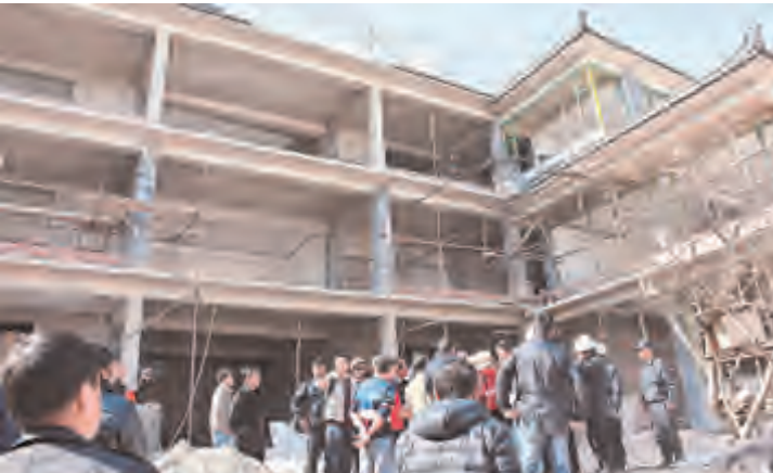
强制拆除违章建筑
