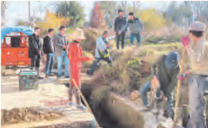
改造排污沟渠
