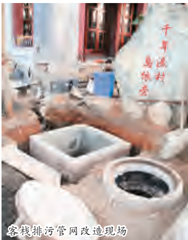
客栈排污管网改造现场
