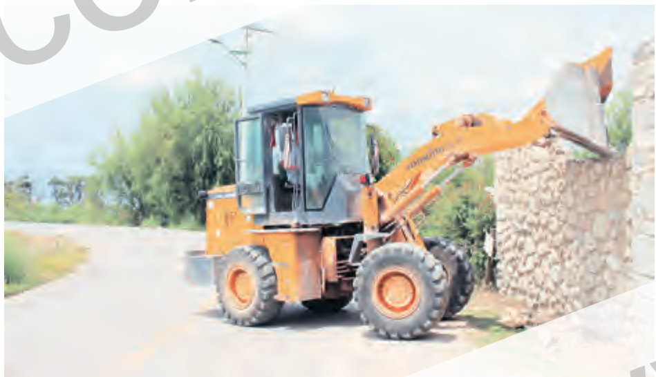
7月15日,大理市对村 19 组环海路一侧一抢占地违法违建建筑进行依法拆除,及时制止违法违规行为,真正做到发现一起查处一起,依法依规整治违法建筑,以实际行动保护洱海。
