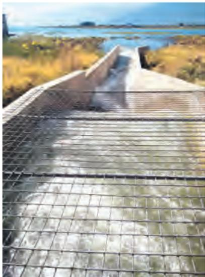
32亩，项目总投资约3300万元。工作中，喜洲镇结合实际分别设计了村落污水、农灌尾水、村落污水和农灌尾水混合三类应急塘，实现污水的“截、汇、蓄、净、用”五大功能，使库塘在成为收纳水体调蓄点的同时，污水经库塘处理后进入农灌系统实现部分回用，既减少排放进入洱海的污染物总量，又利用库塘闲置水域及土地进行经济作物种植，产生的效益达到了以塘养塘的目标。
